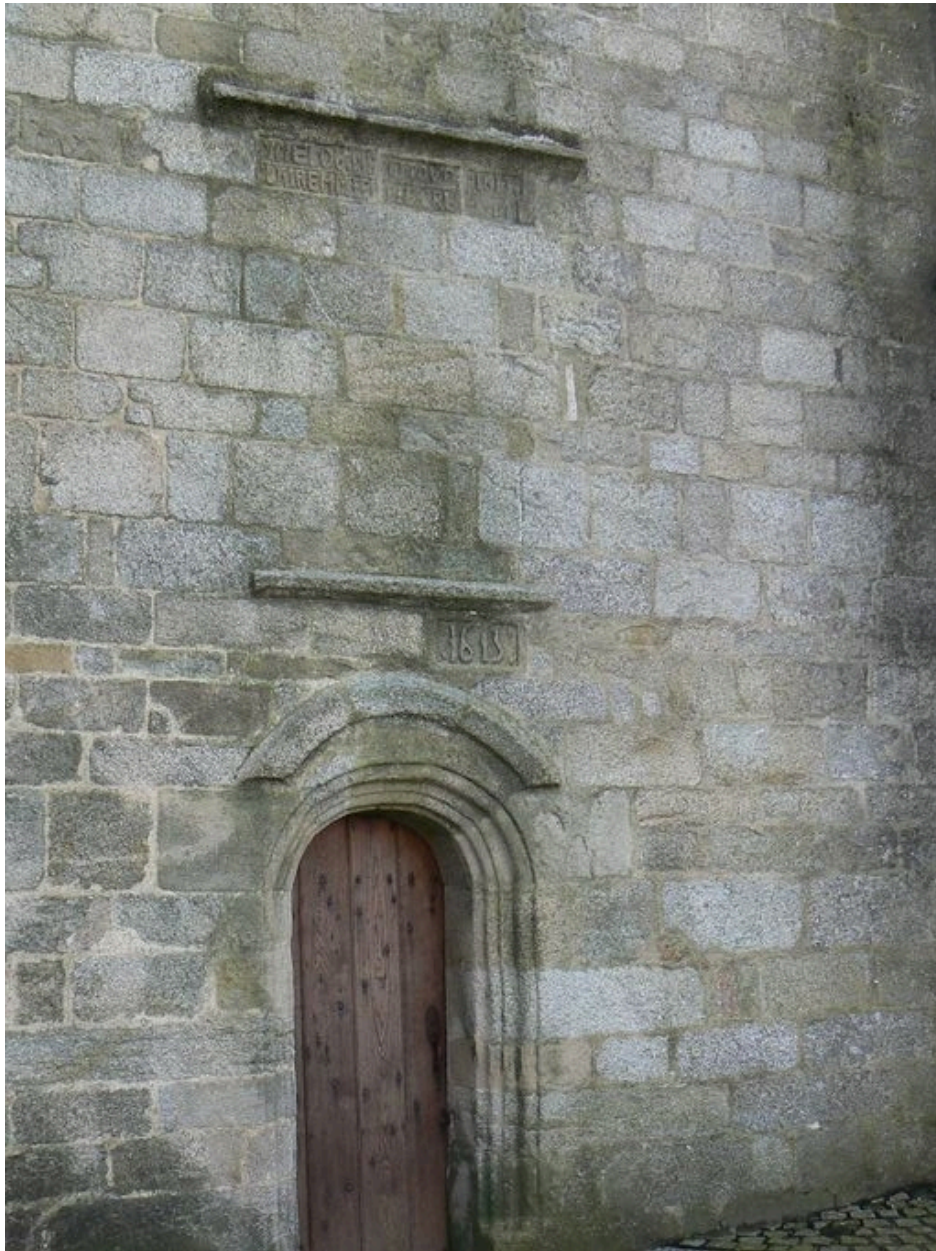
Détail du porche de l'église Notre-Dame-de-Larmor
