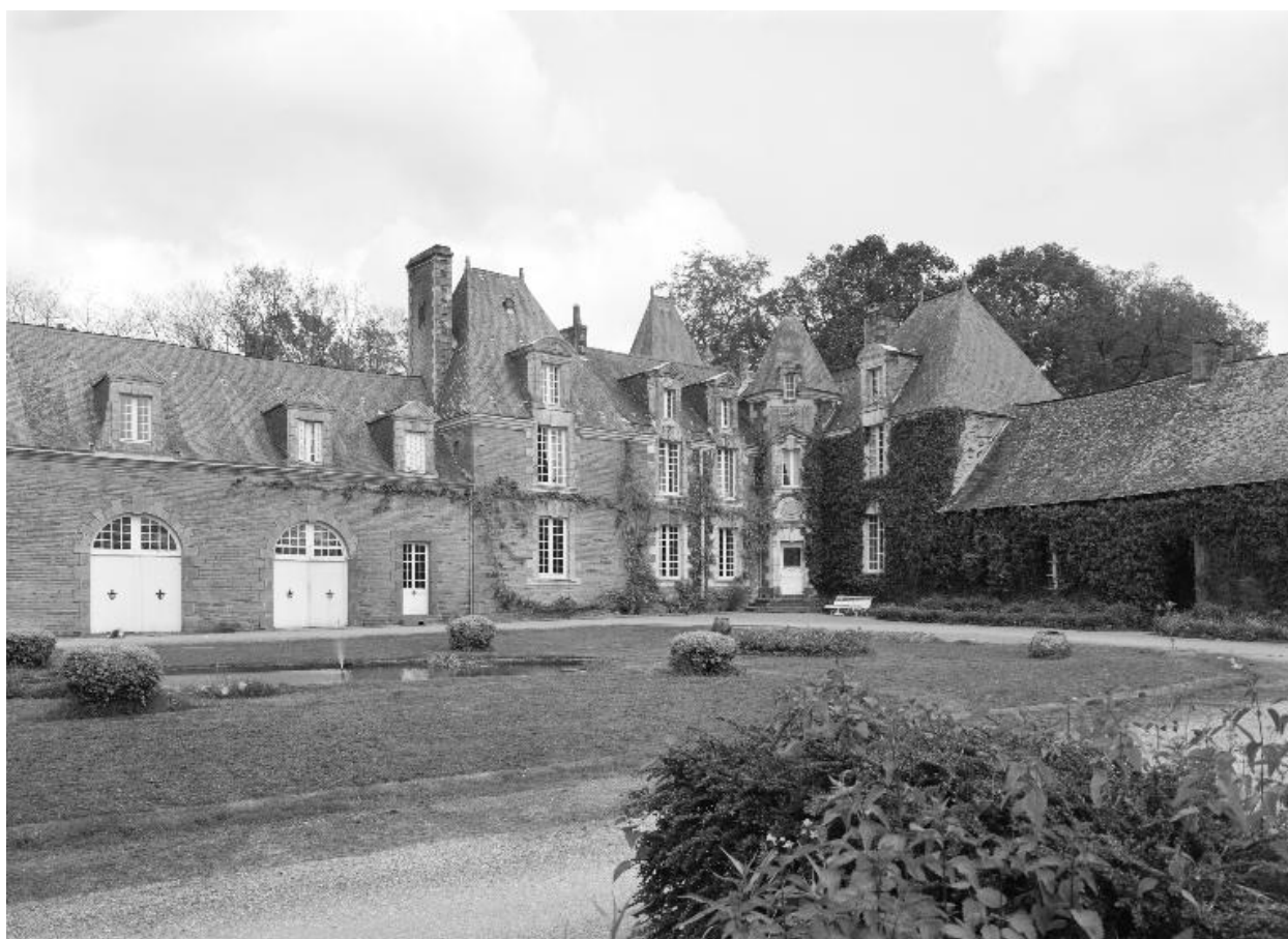
Château vu du sud-ouest (état en 1983)
