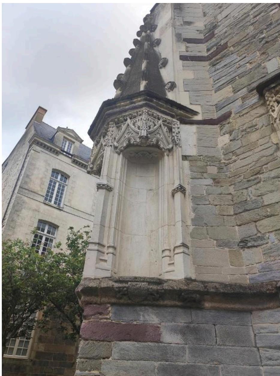
Détail du contrefort creusé de niches sculptées à l'angle des rue Saint-Yves et Le Bouteiller
