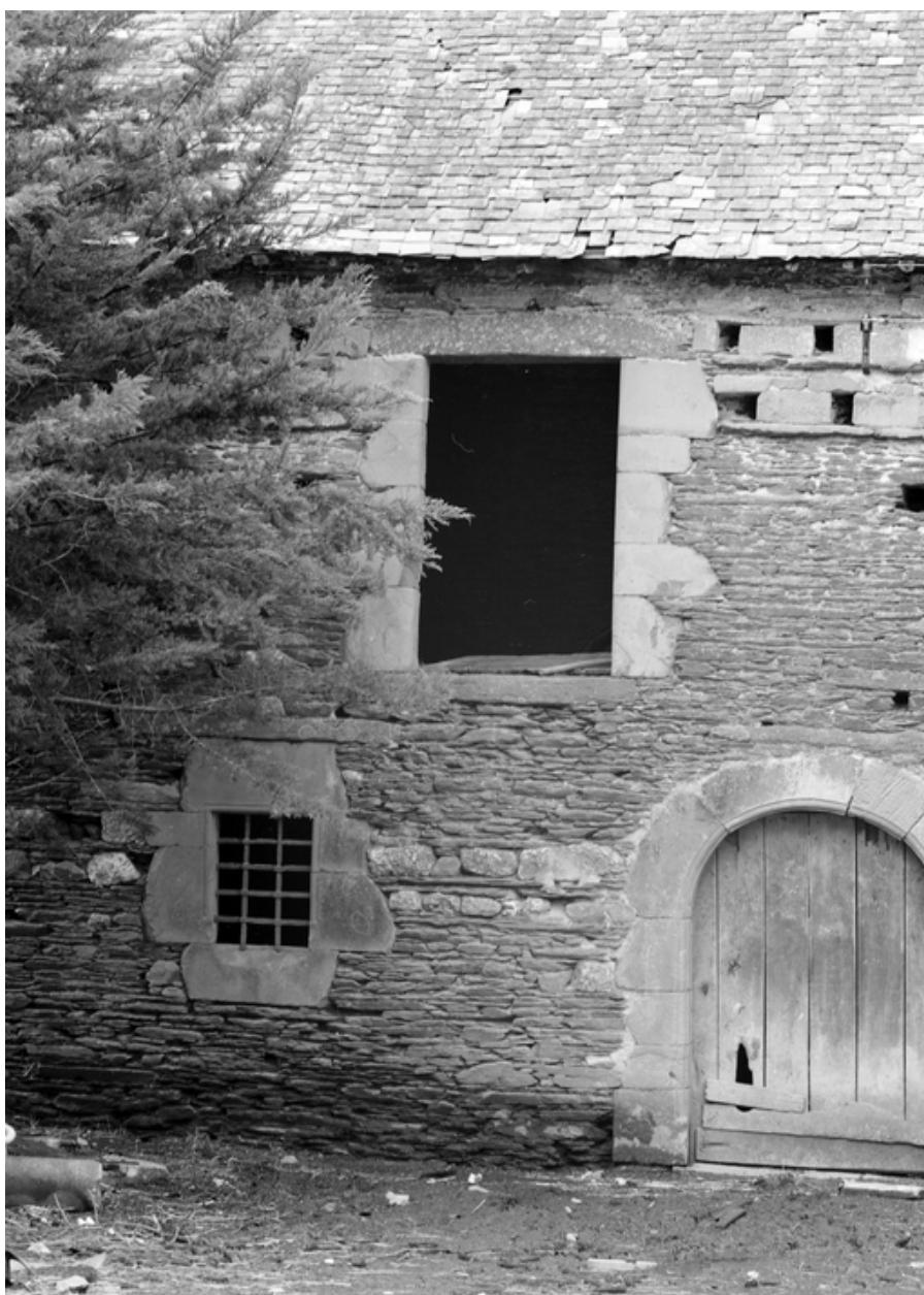
Dépendance nord, détail des baies.
