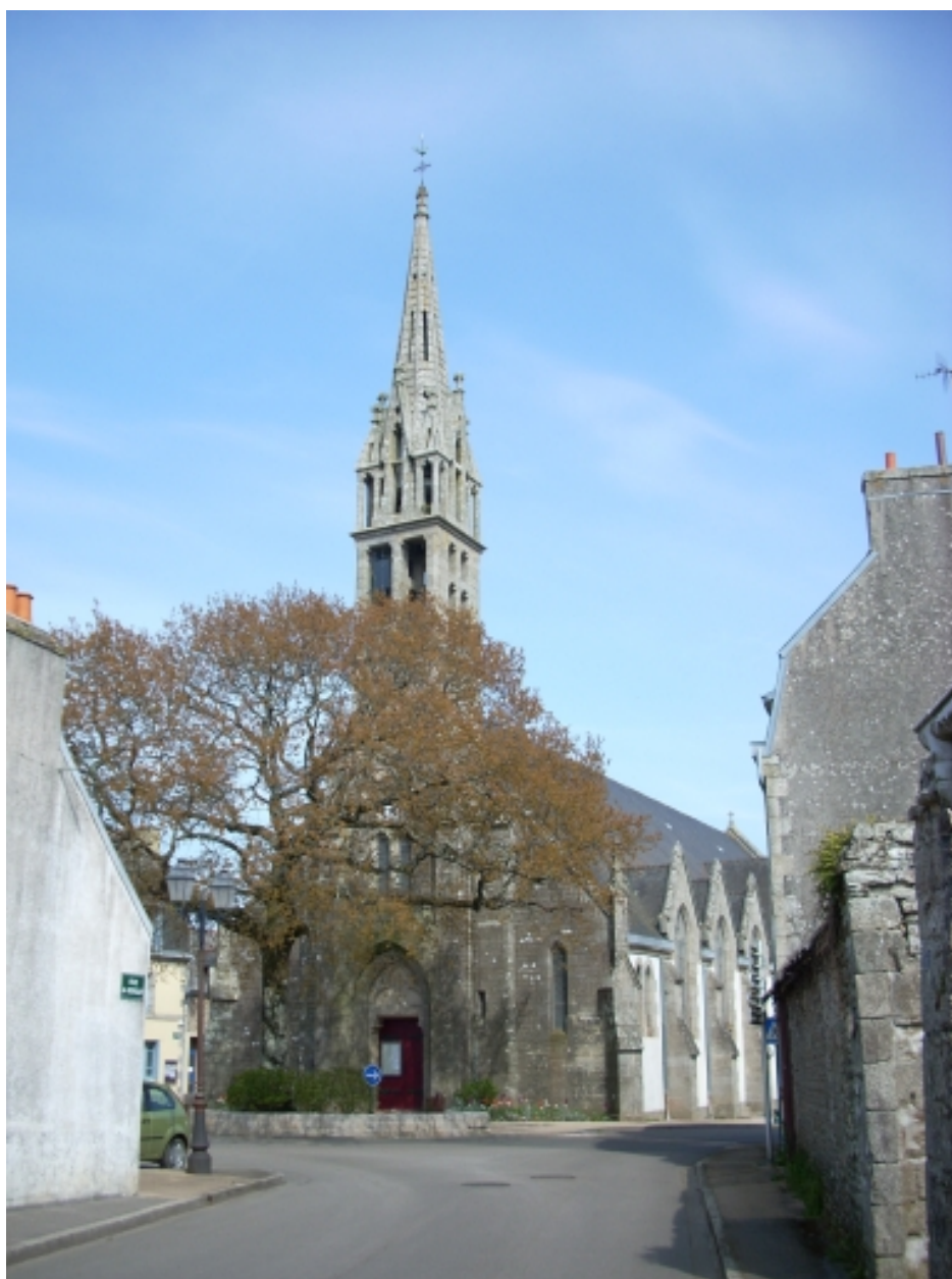
Concarneau, Beuzec-Conq, église Saint-Budoc : vue générale sud-ouest
