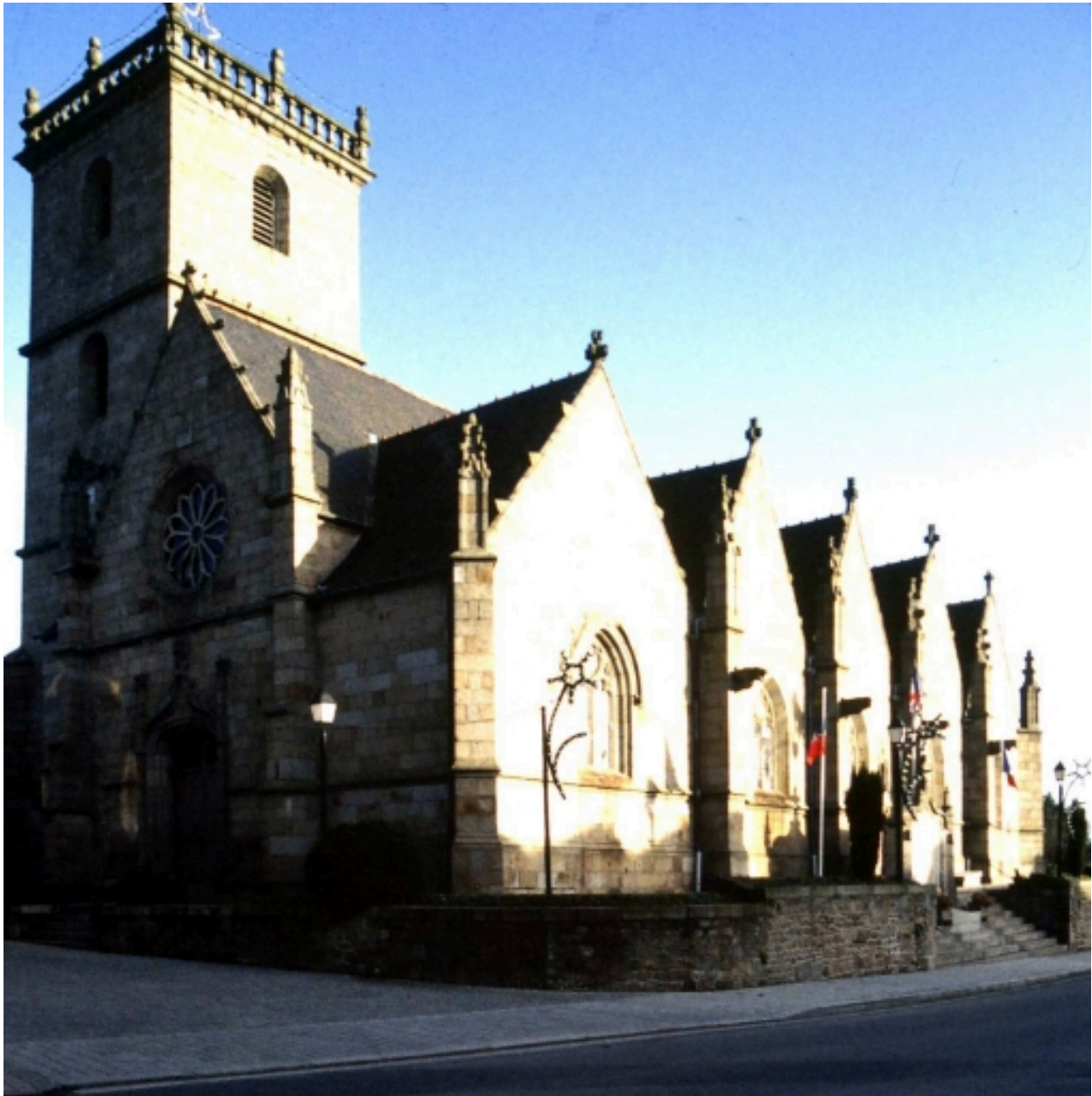
Vue d'ensemble prise du sud ouest.
