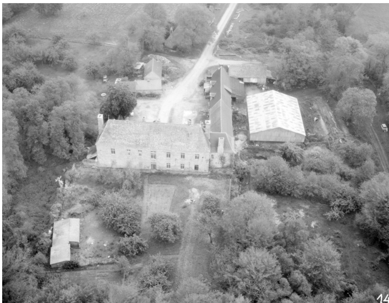
Vue aérienne : vue générale nord
