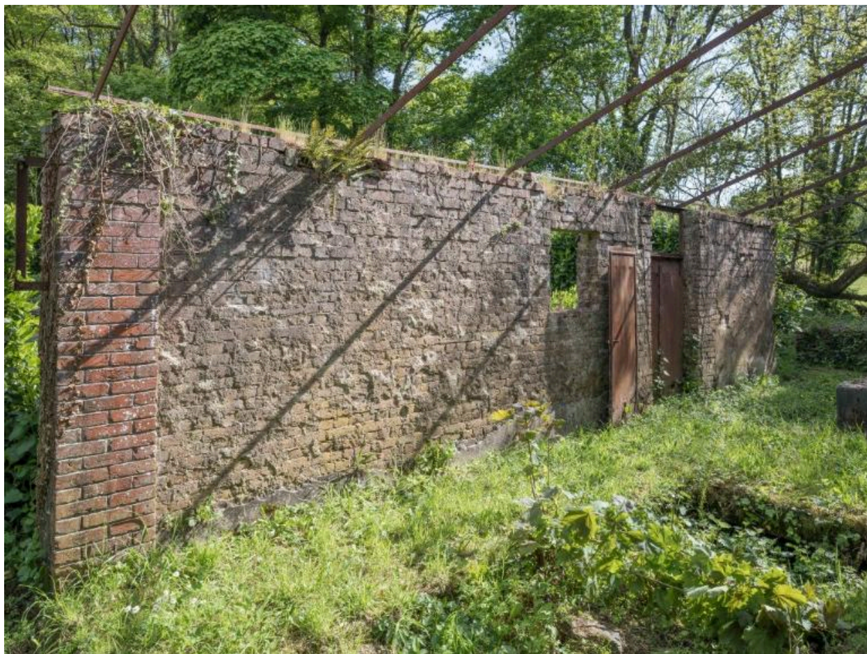
Bâtiment principal. Mur de l'appentis sud-est
