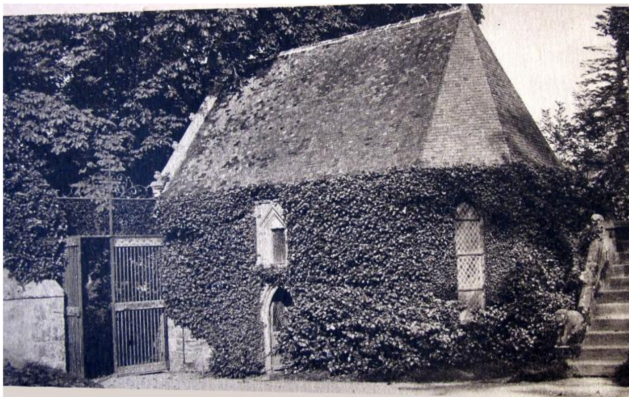
La chapelle, photo CRMH, vers 1972
