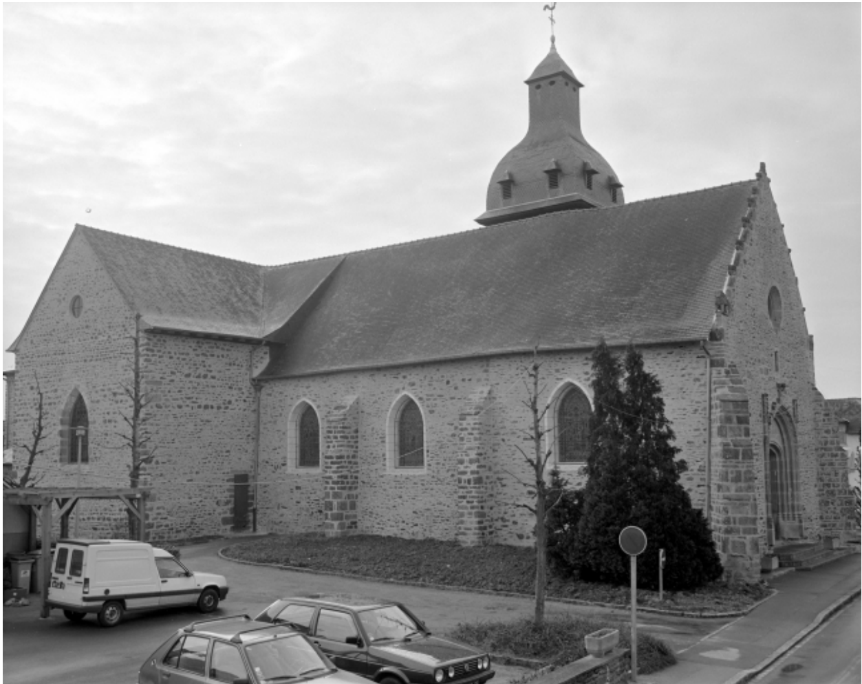
Elévation Nord : vue générale, état en 1972
