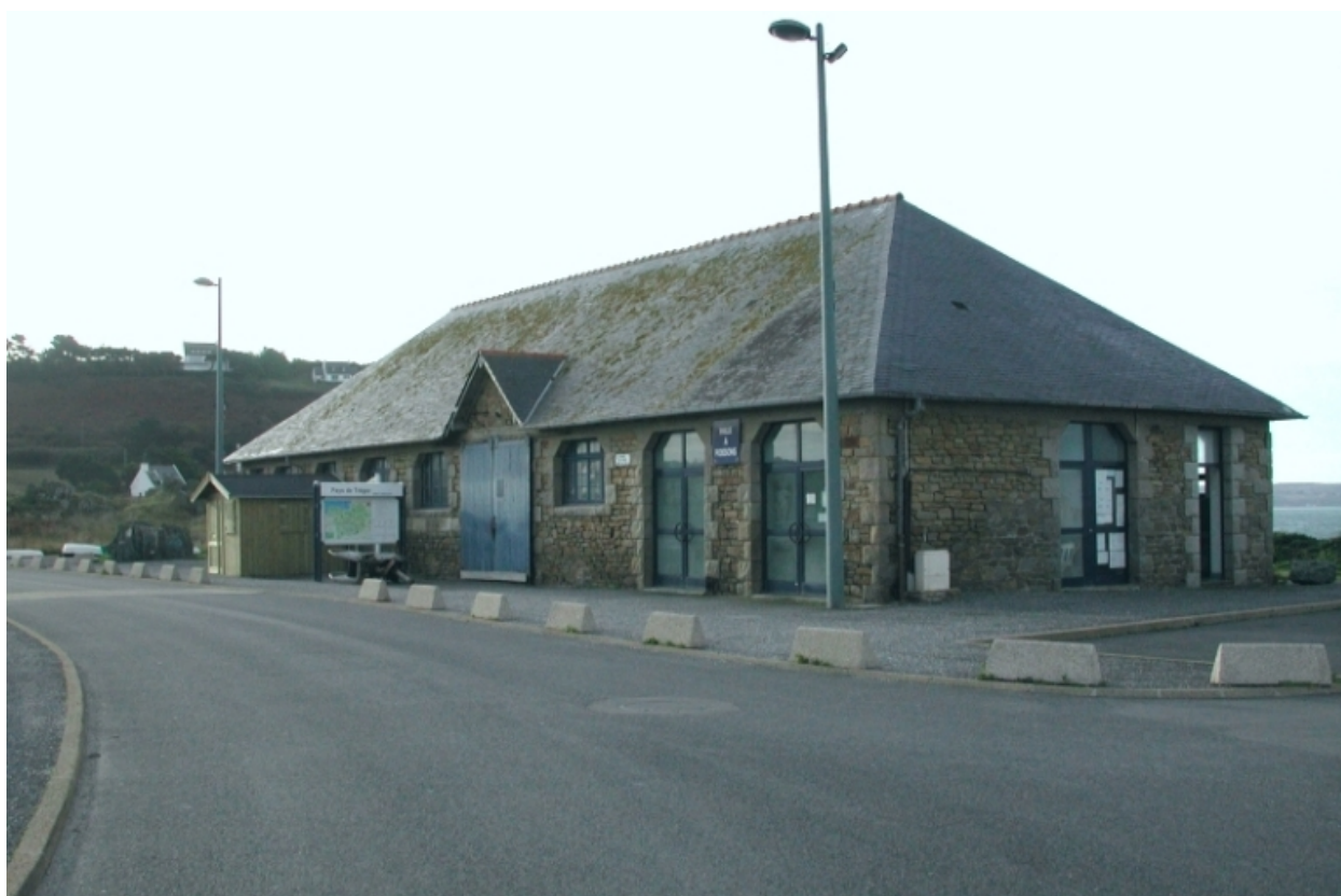
Vue générale des halles
