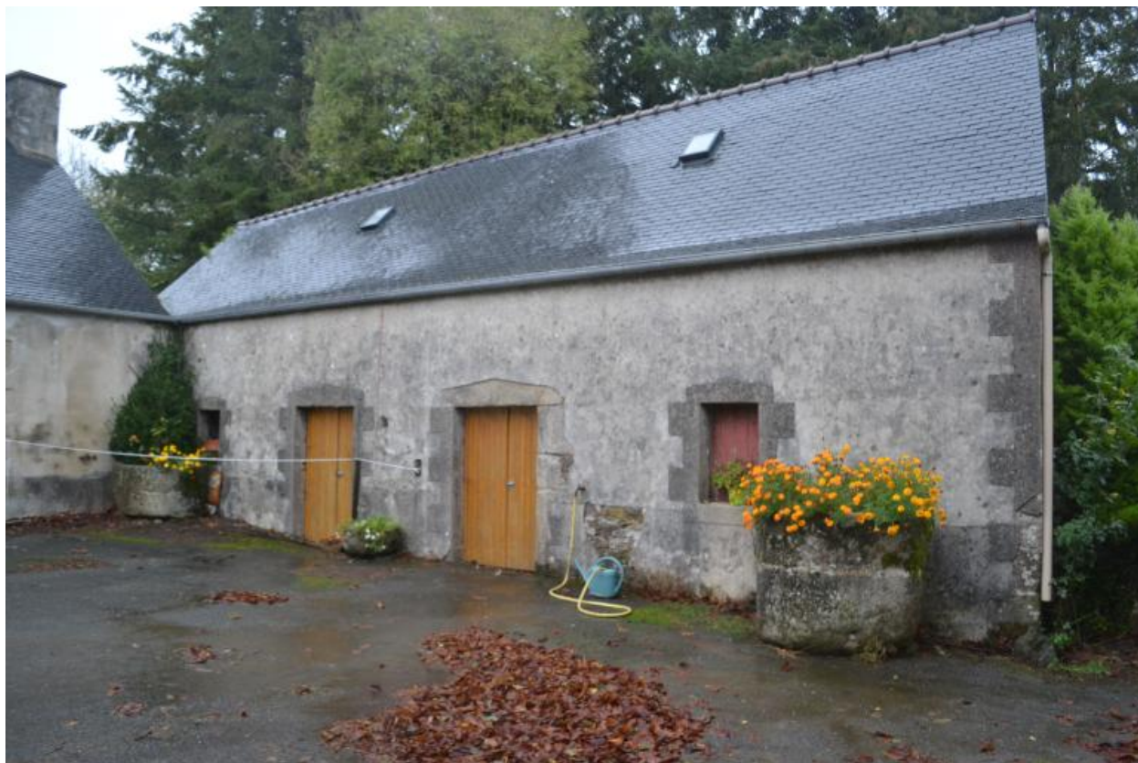
Atelier de tissage. Vue générale sud-ouest
