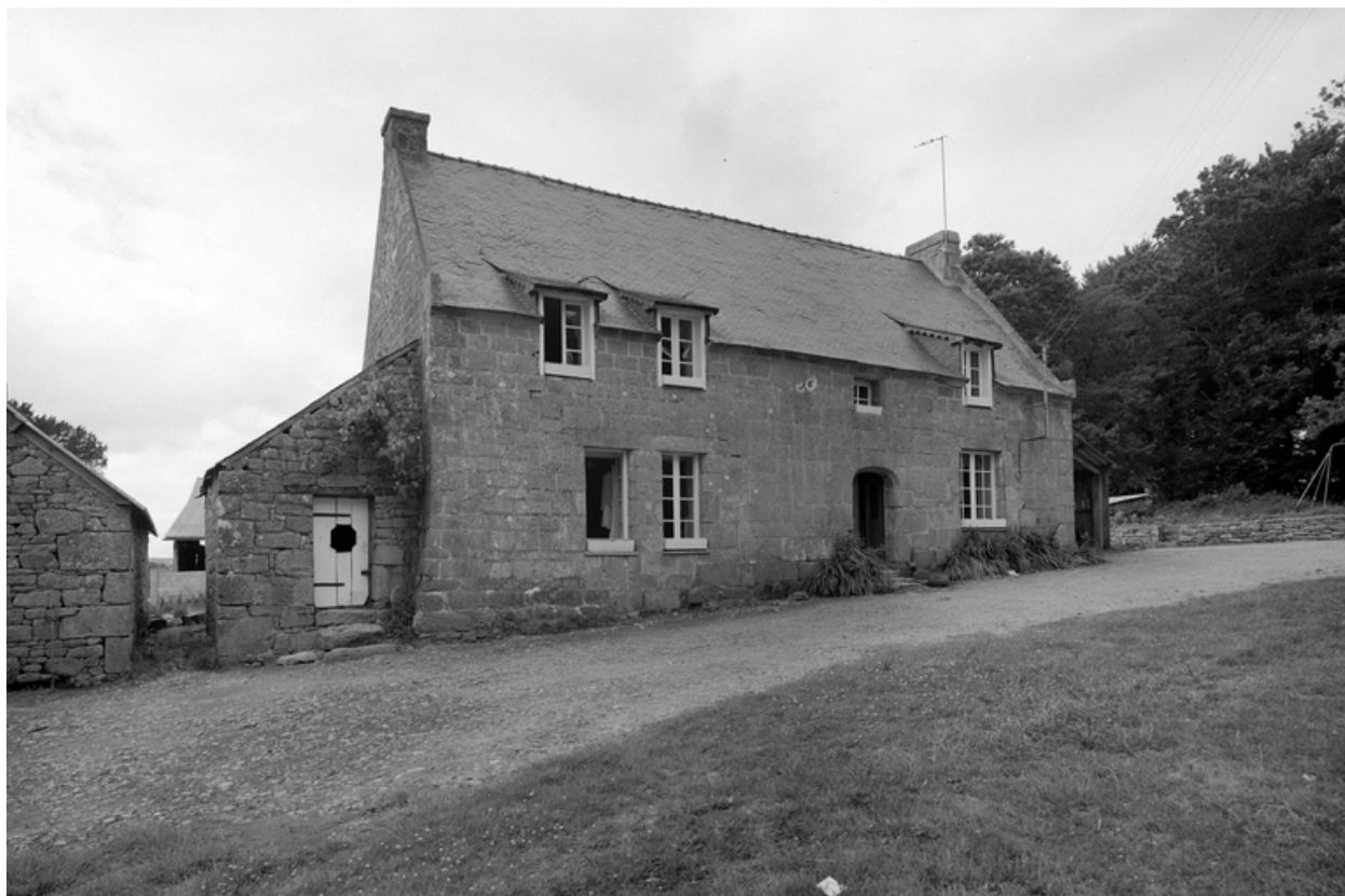
Elévation sud : vue prise du sud ouest
