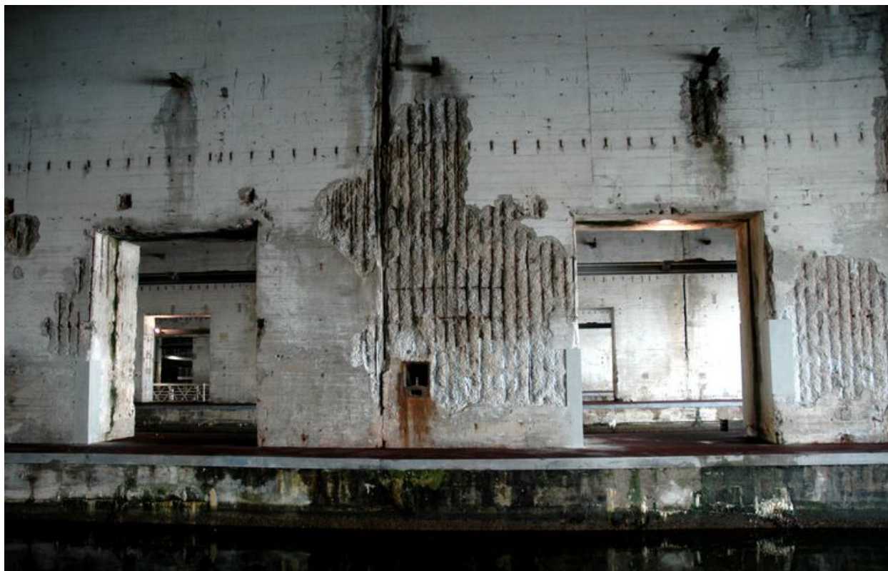
Vue de l'intérieur de la base de sous-marins
