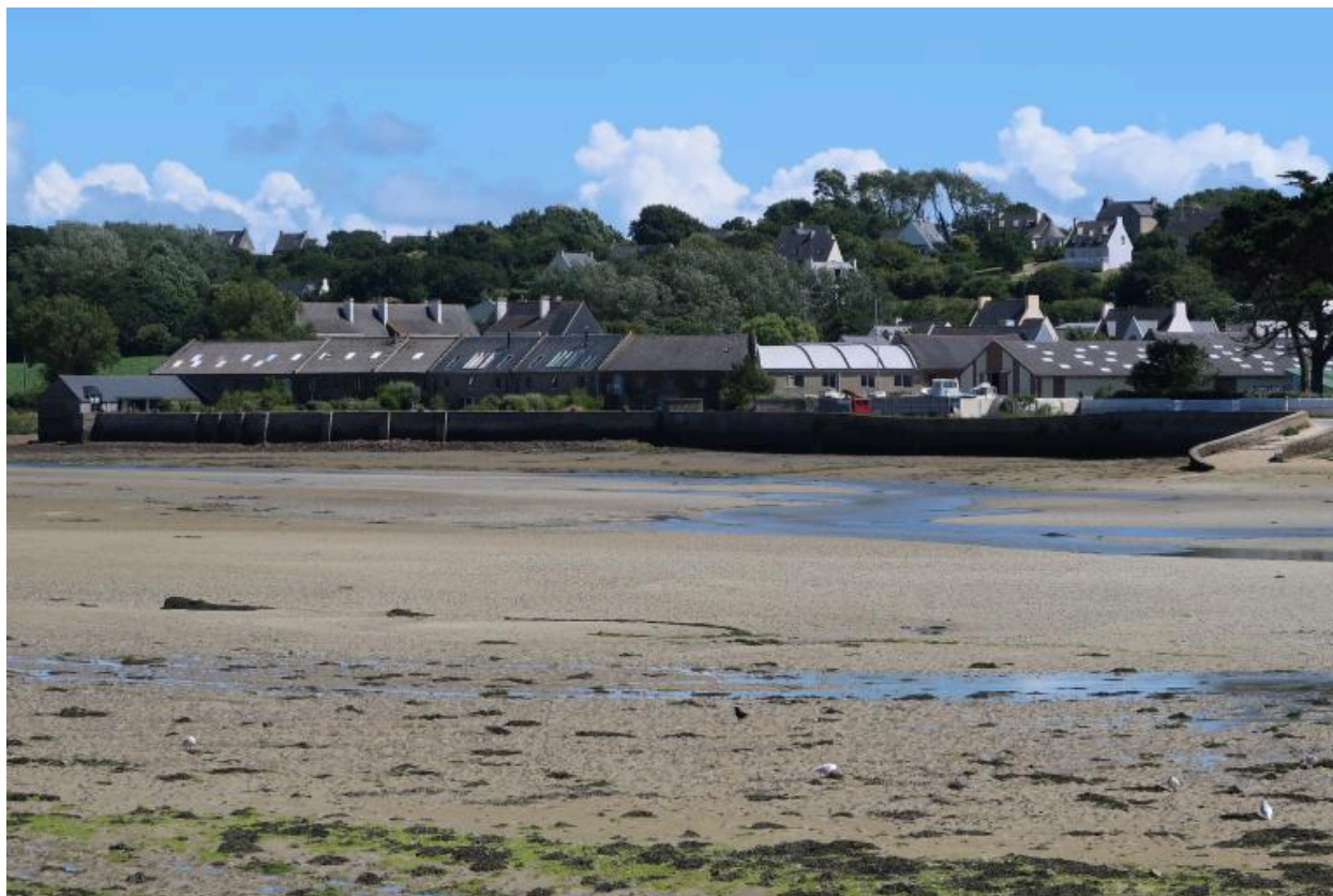
Ancienne usine Tissier réhabilitée en logements
