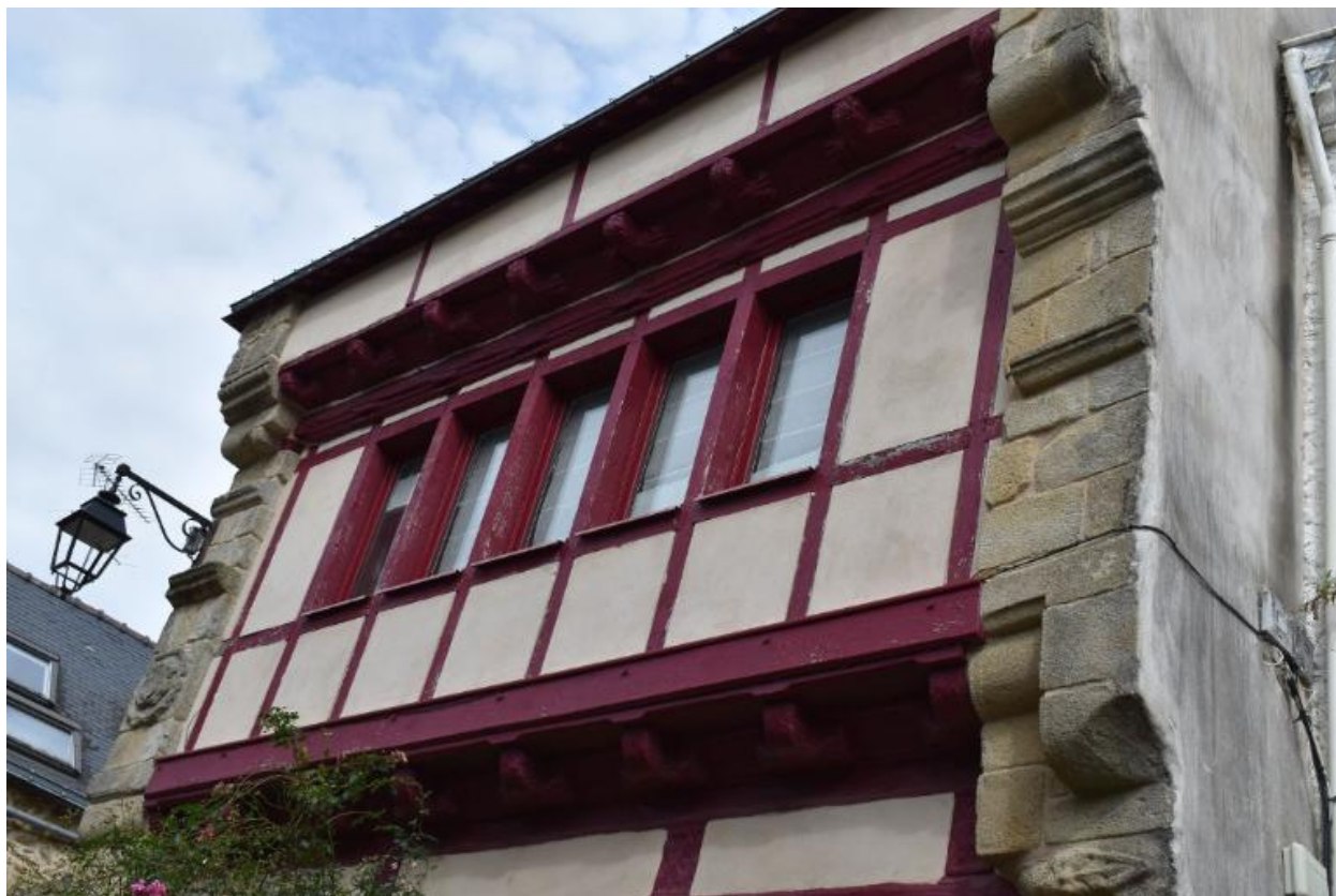
Détail de l'encorbellement du premier étage
