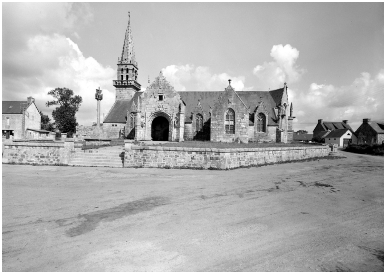
Vue générale sud de l'église et du placître
