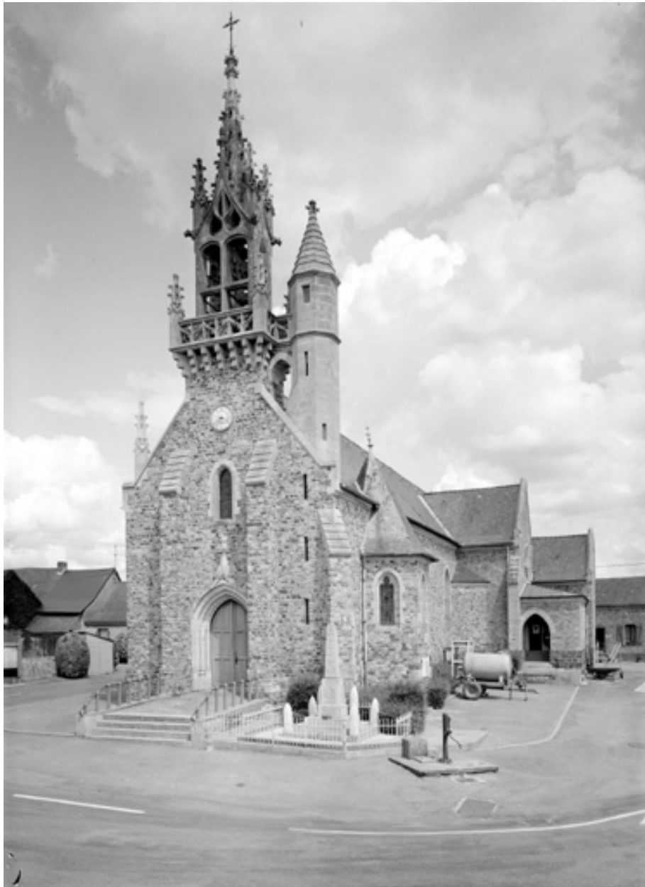
Elévation Ouest : vue générale
