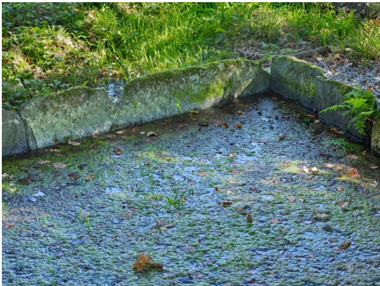
Lavoir. Détail des dalles de schiste posées sur chant
