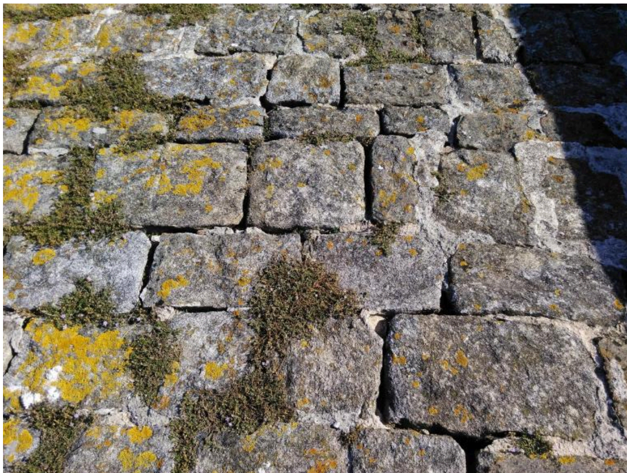
Môle, maçonnerie du cantelage (détail)
