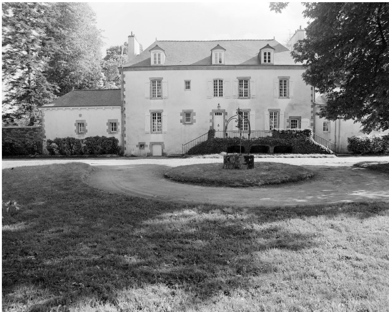
Elévation nord, vue générale.
