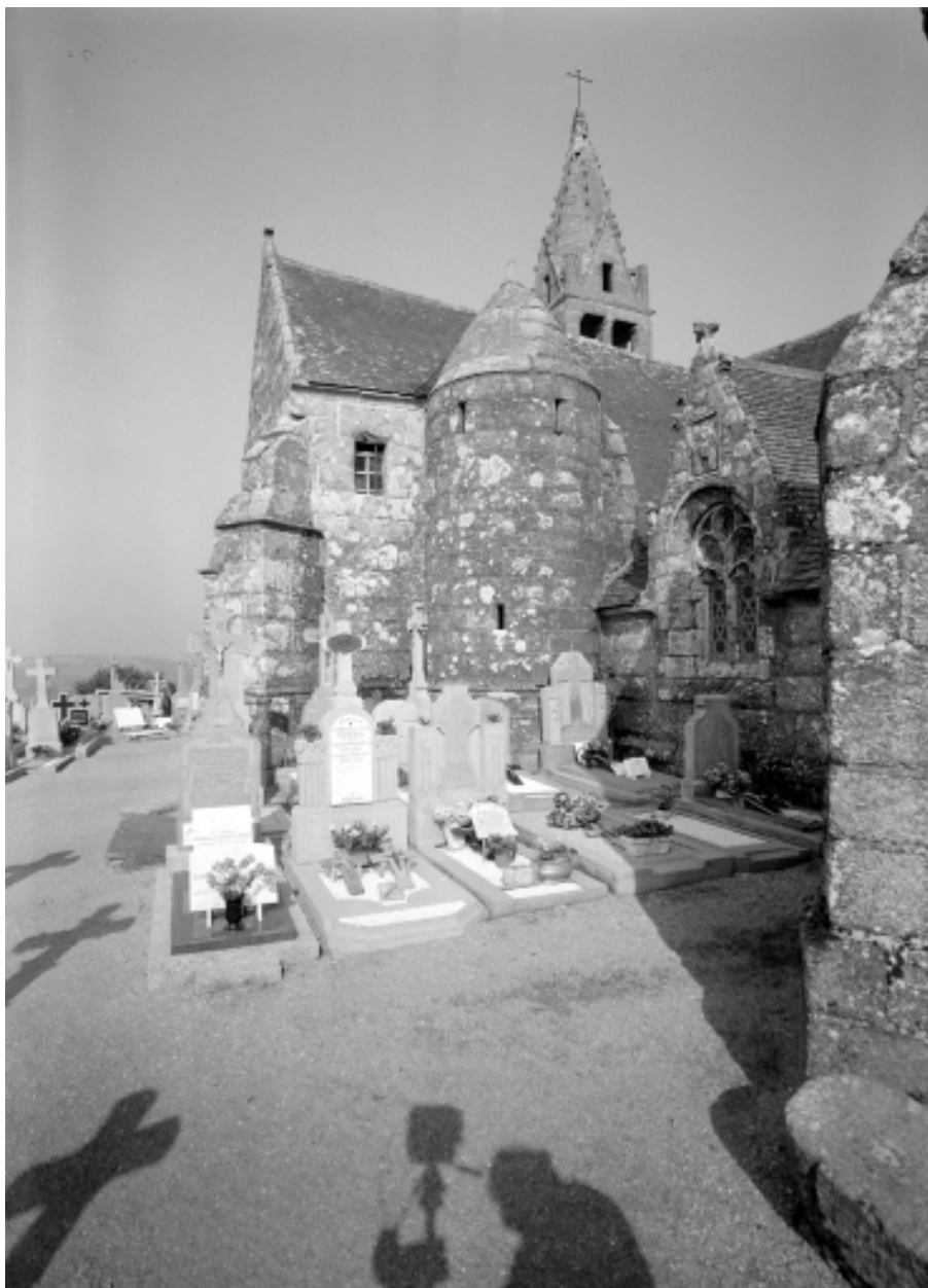
Porche sud et tourelle d'escalier, vue prise de l'est
