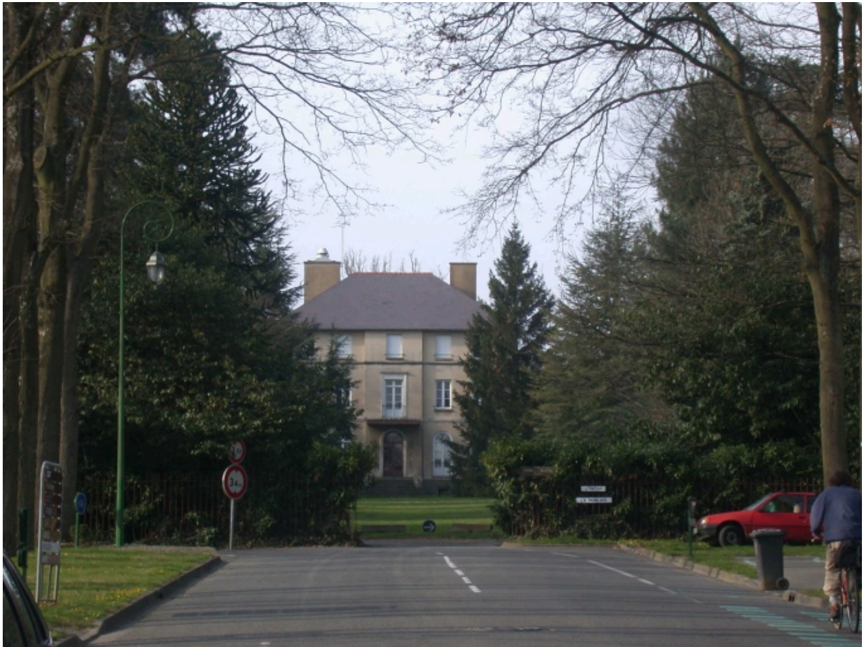
Vue générale prise de l'allée de la Hublais
