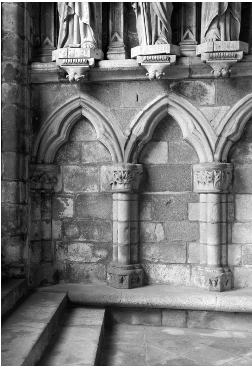
Porche sud, intérieur : mur ouest, détail des arcades 1 et 2 au sud
