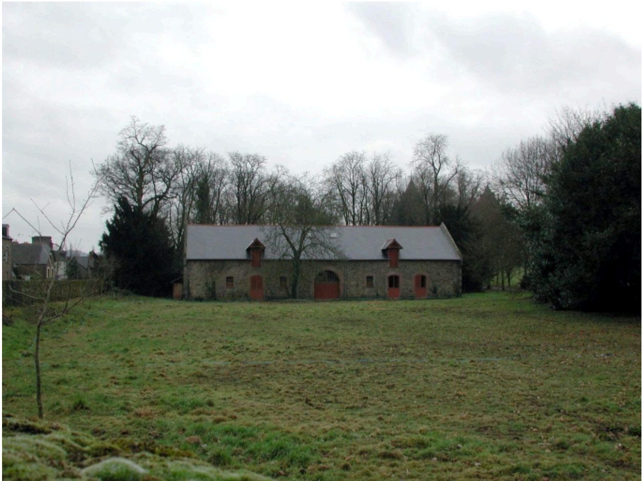
Communs, vue générale nord
