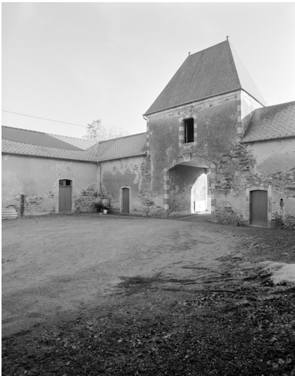
Ferme, vue intérieure de la cour.
