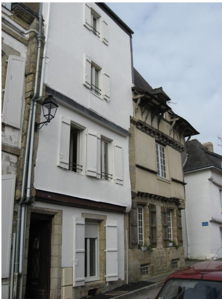
Vue générale, façade sur rue
