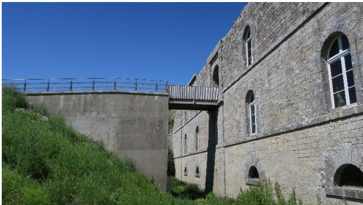
Hœdic, fort central, caserne à l'épreuve, façade ouest.
