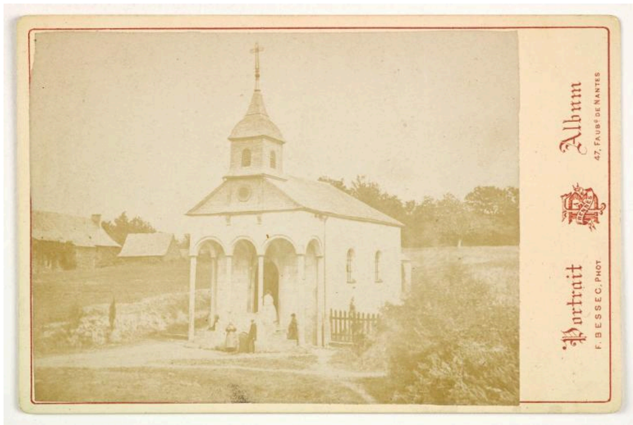
Façade de l'oratoire qui a précédé la chapelle, construit en 1839-1940
