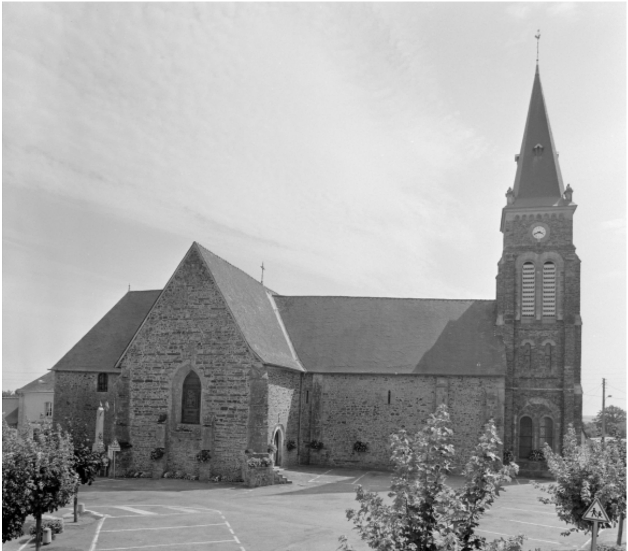
Elévation Nord : vue générale
