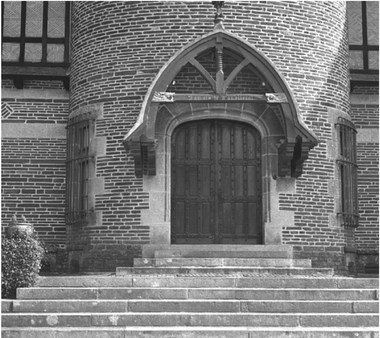
Détail : façade ouest, porte d'entrée
