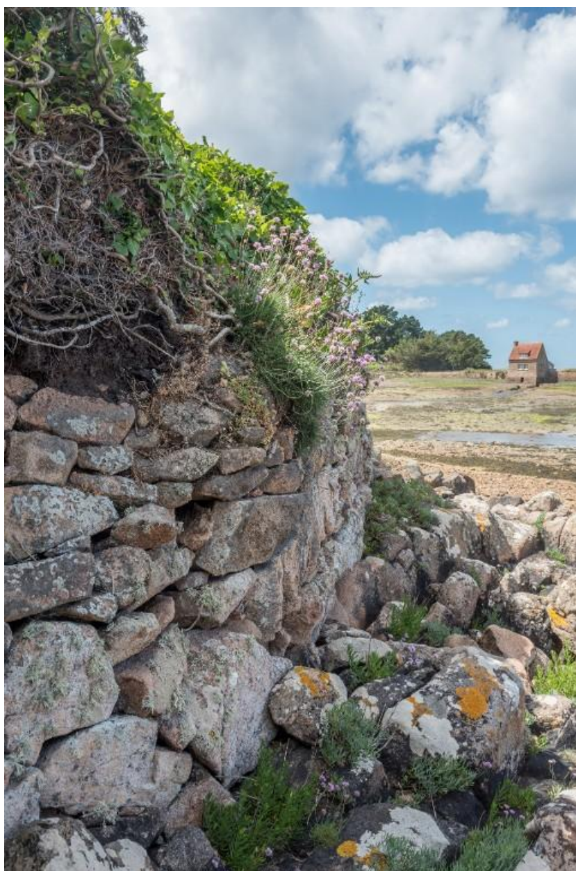
Vue du mur de soutènement orienté Nord sur lequel pousse de l'armérie maritime aux fleurs roses, faisant face au moulin à marées des îles Balanec et Ozac'h
