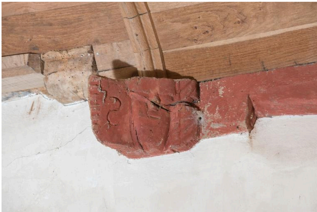
Vue de détail : blochet d'angle à l'extrémité est de la sablière sud
