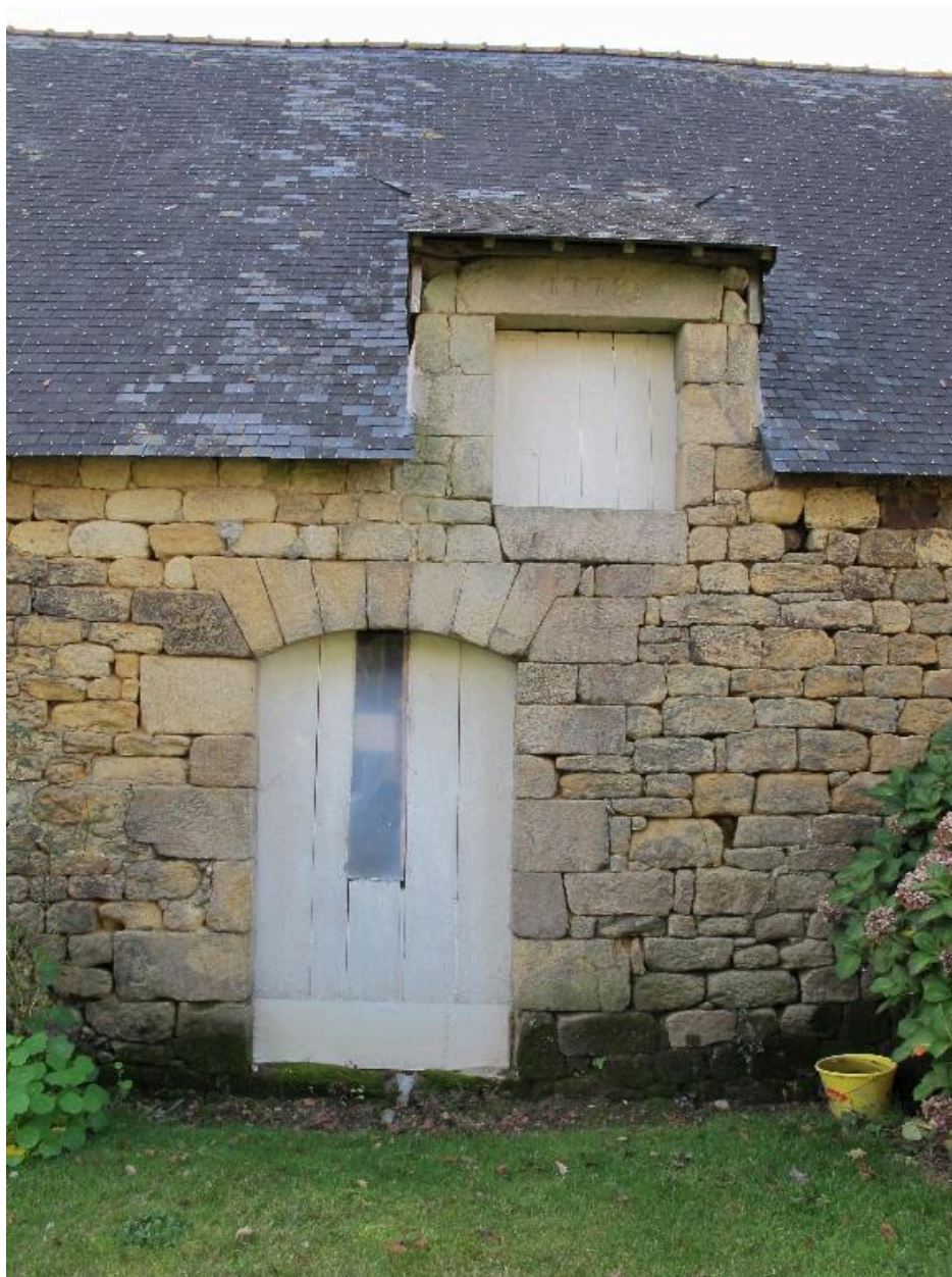
Ferme, détail de la porte de l'étable et de la fenêtre de grenier datée 1778, état en 2015
