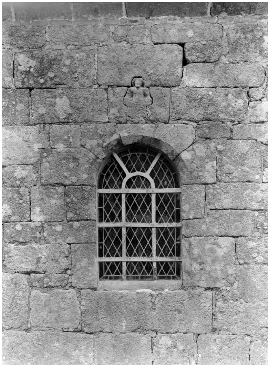
Vue extérieure de la fenêtre de la chapelle des fonts
