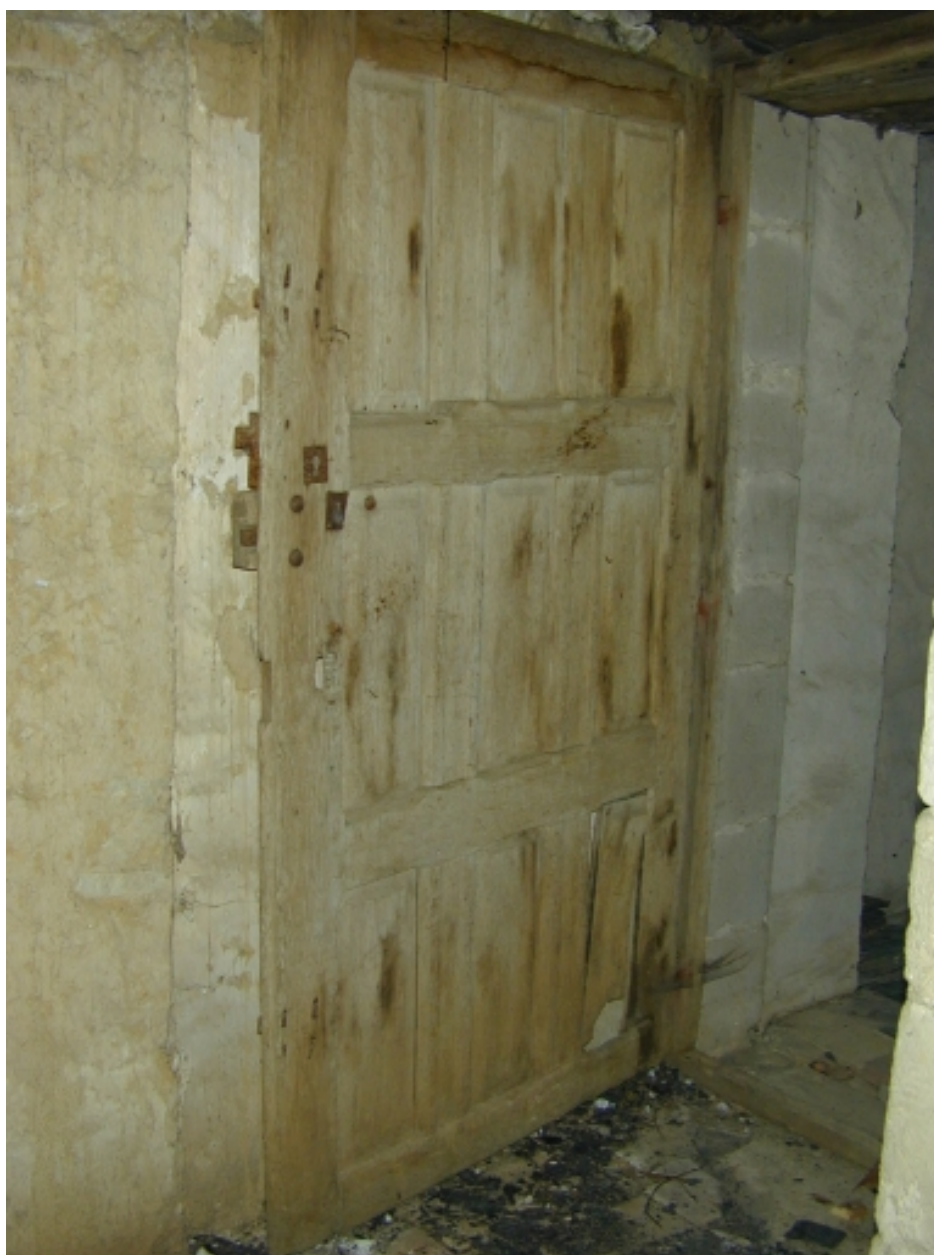
Intérieur, étage de comble, porte du 17 e siècle
