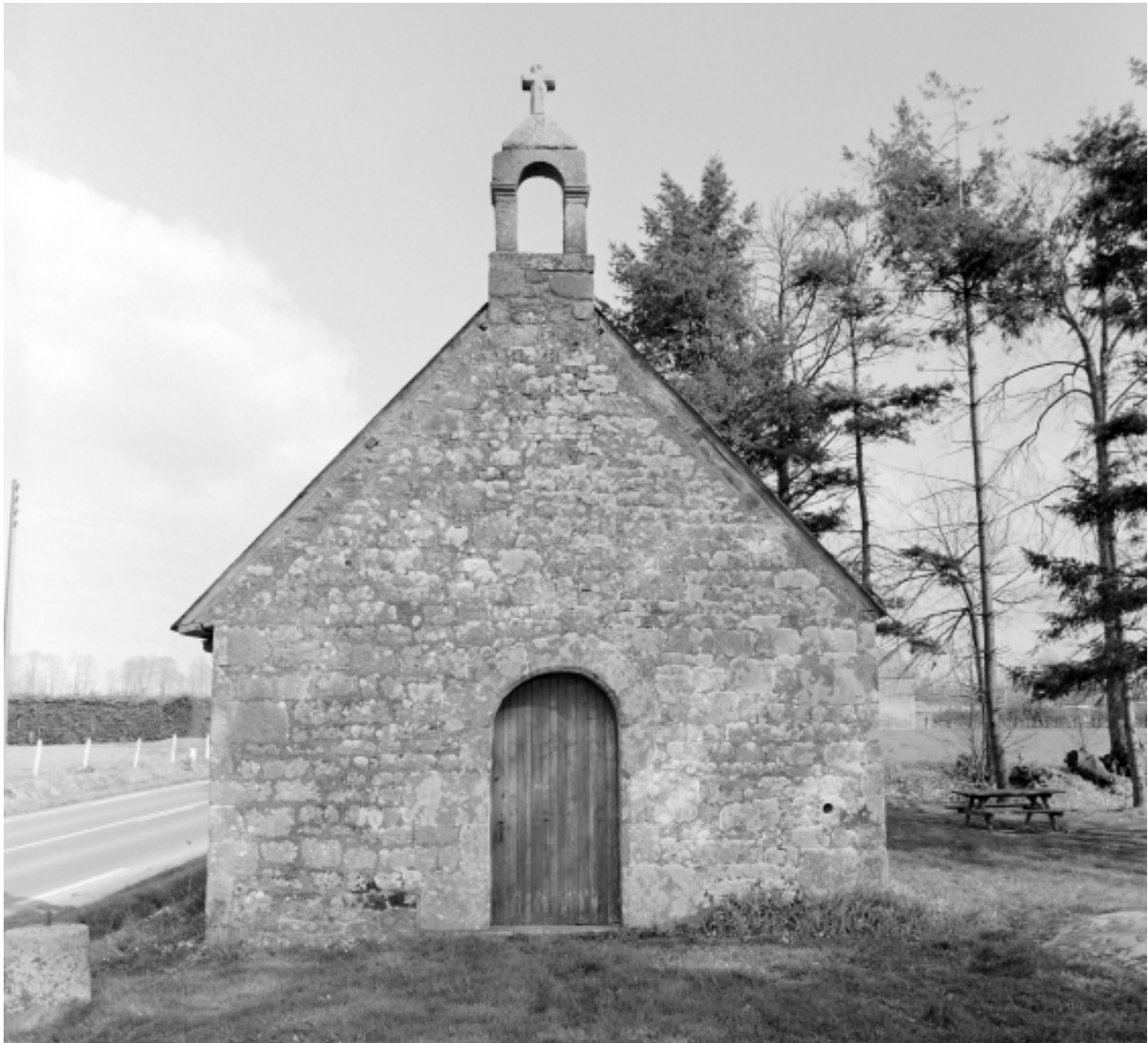
Élévation Sud-Est : vue générale
