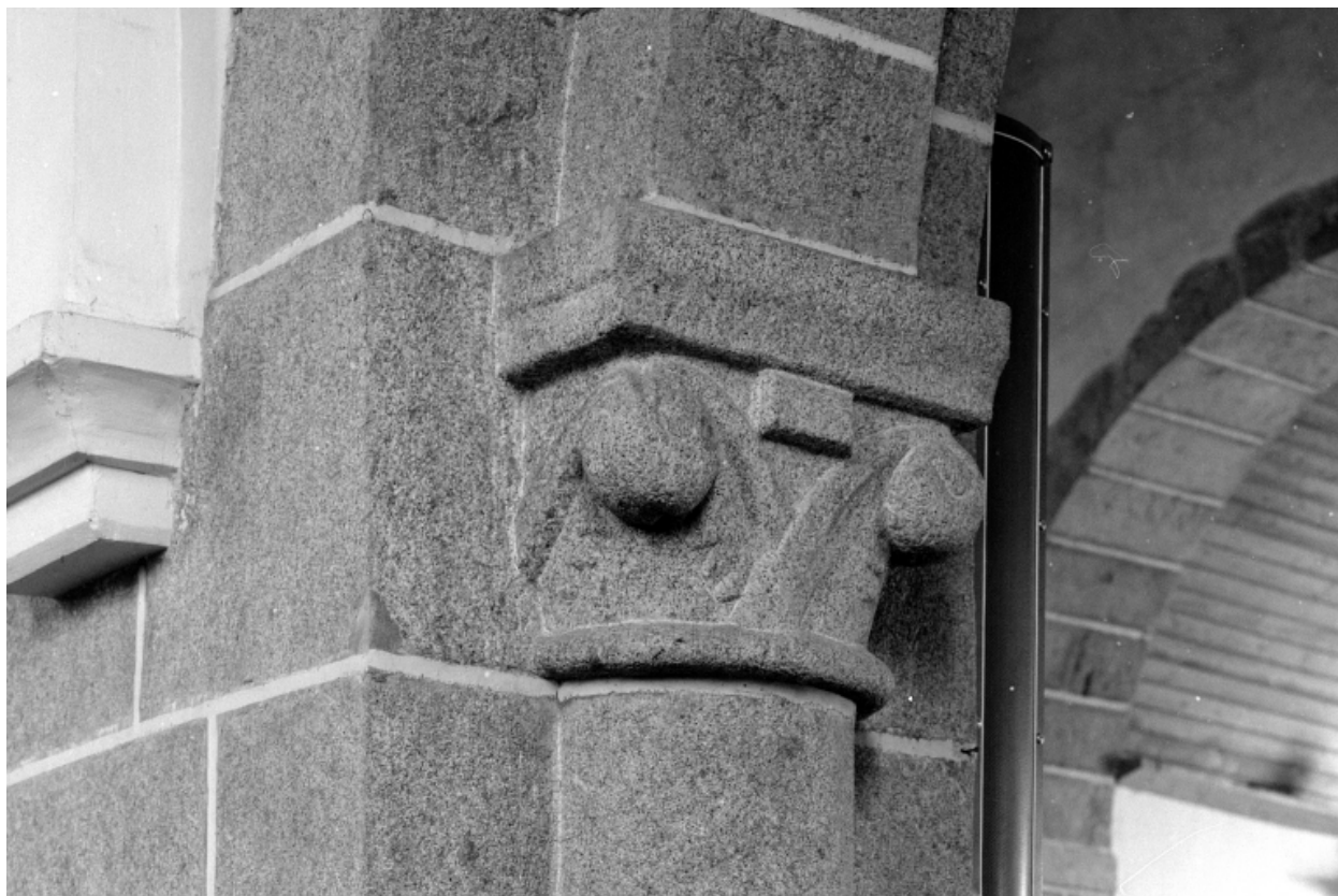
Intérieur, arcade Nord : détail du chapiteau Ouest.
