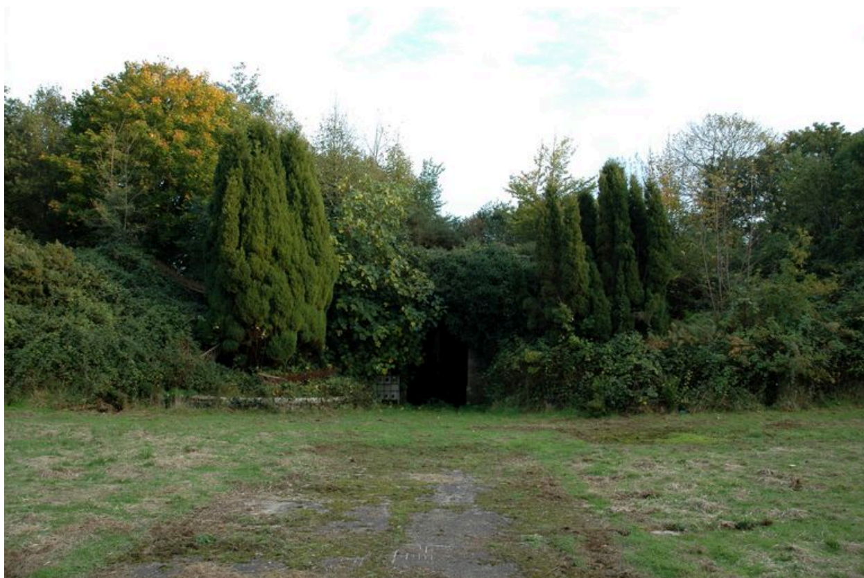
Vue du fort de Penfeld : le passage d'entrée est envahi par la végétation
