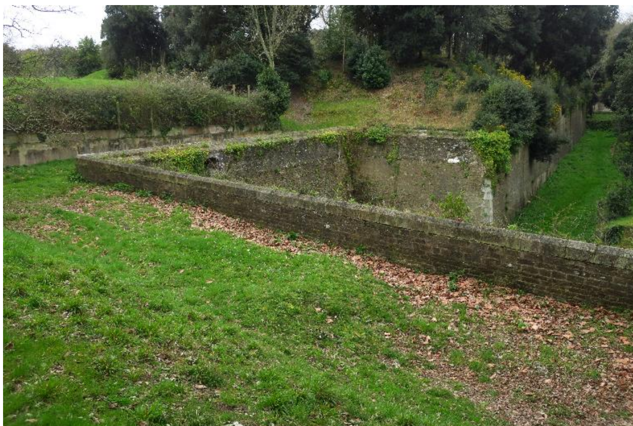
Le Palais, enceinte urbaine, bastion 21, face droite, jonction avec la courtine 21-22.
