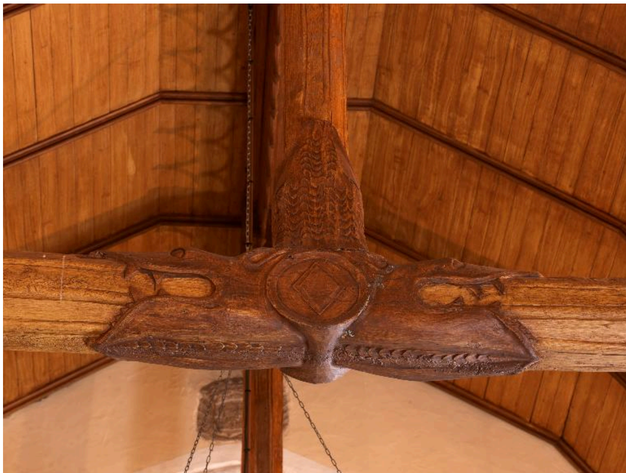
Engoulants de la charpente
