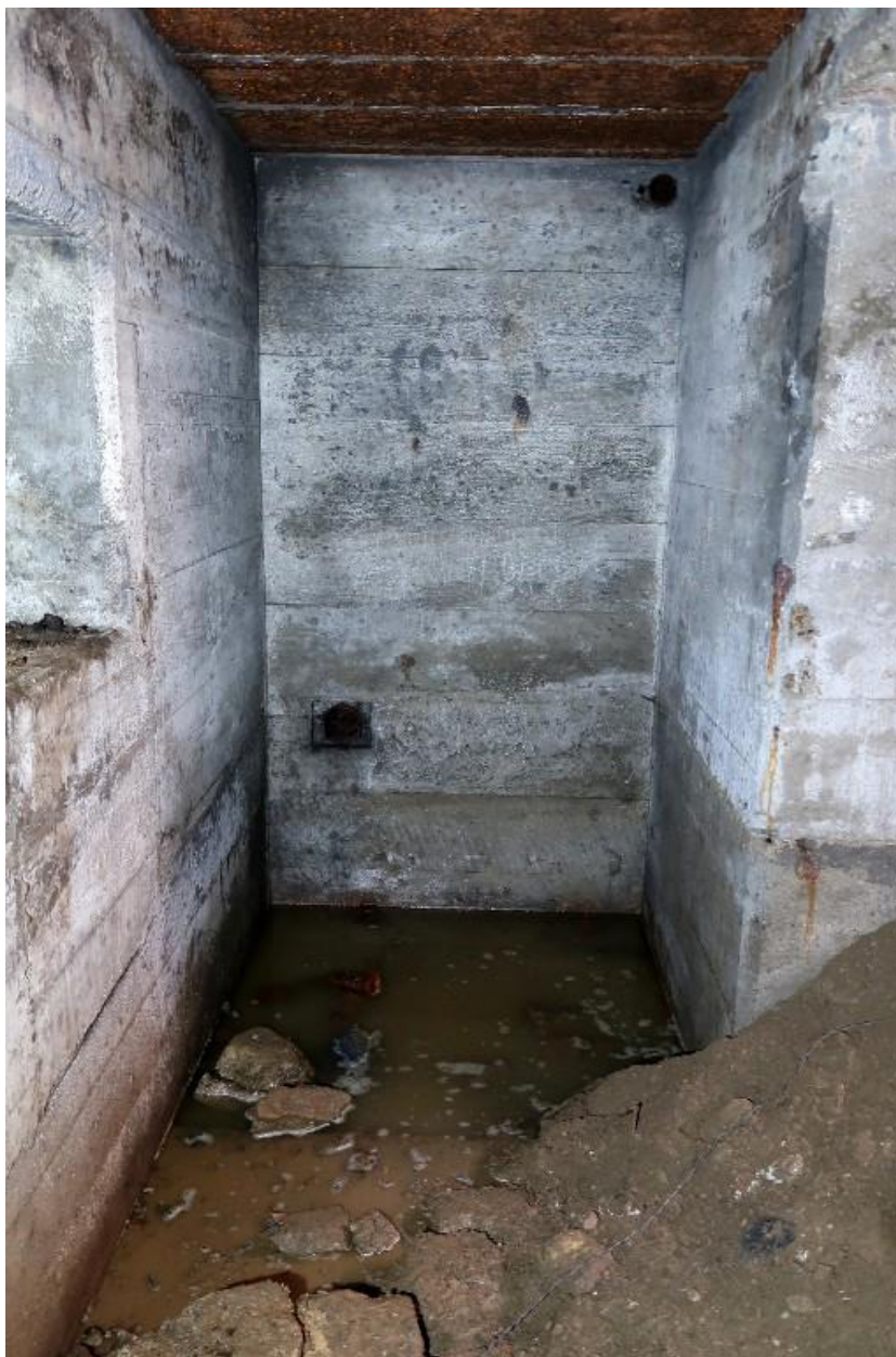
Vue du l'entrée nord : couloir d'accès flanqué par un créneau de tir, extrémité nord du couloir
