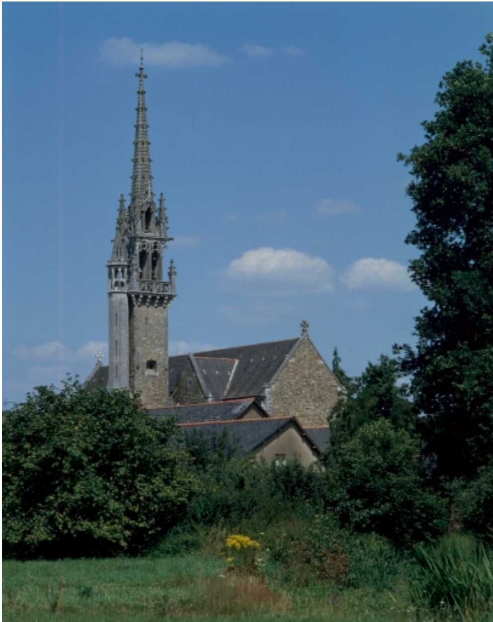
Elévation sud : vue générale
