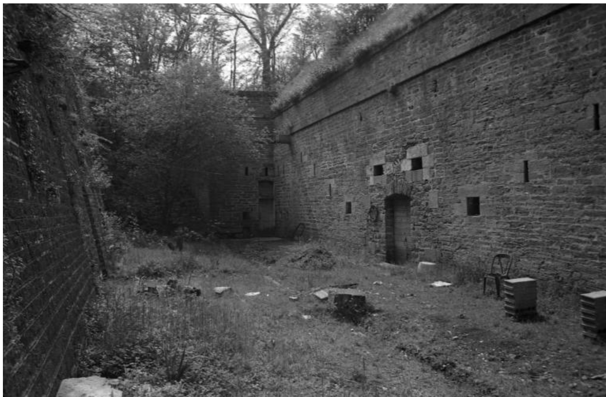
Le Palais, enceinte urbaine, réduit A, façade bastionnée, état dans les années 1970.
