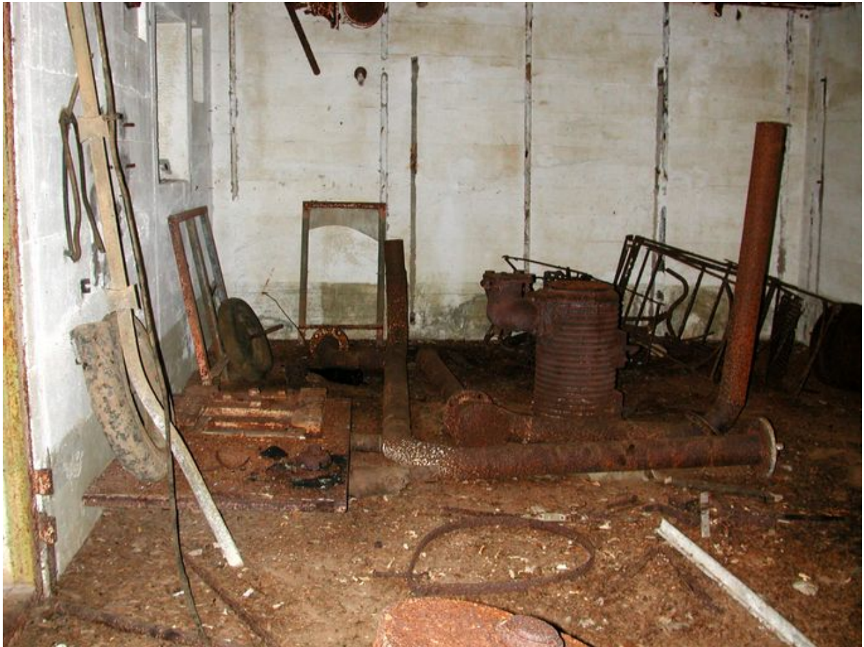
Vue de la chambre de troupe de gauche : poêle de type Wt 80K et tuyaux de ventilation... (état en 2003)
