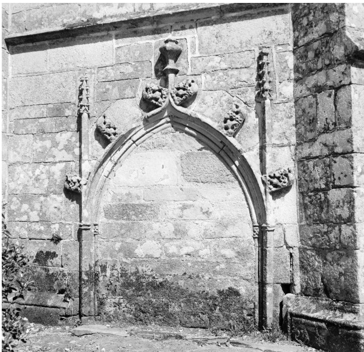
Porte bouchée sur la face ouest du bras sud du transept : vue rapprochée
