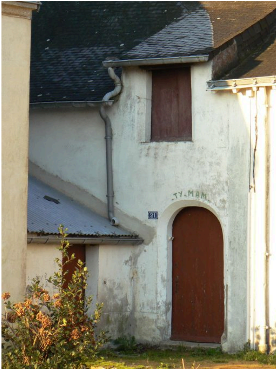
Vue générale de la maison dite Ty Mam
