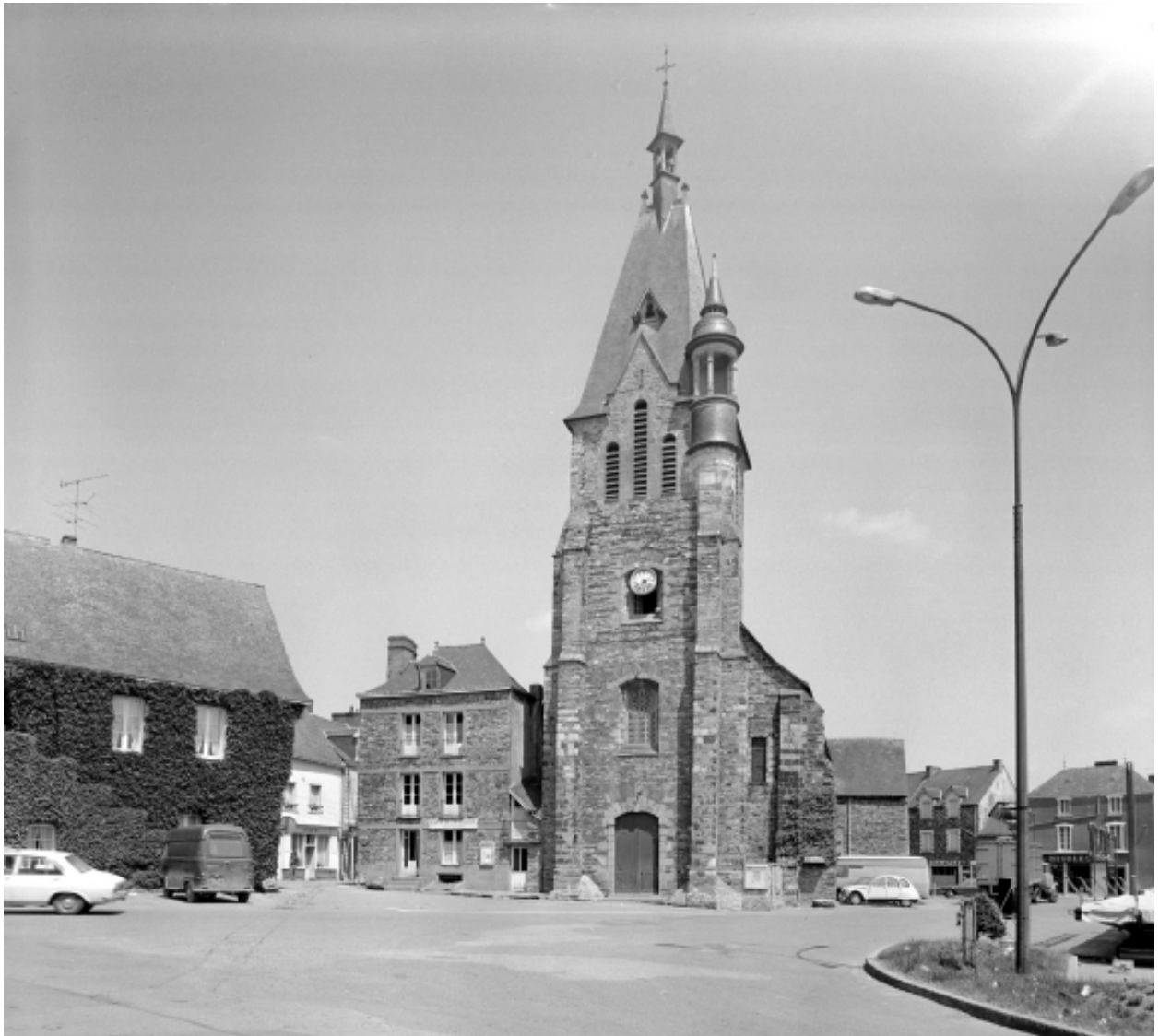
Elévation ouest : vue générale.
