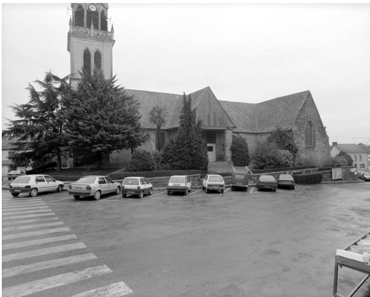
Vue partielle sud
