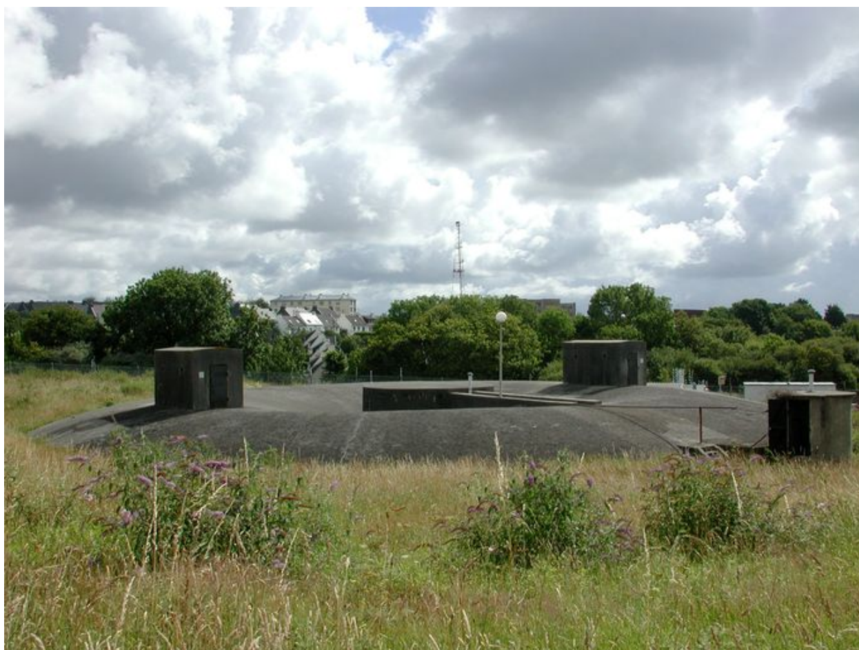
Vue de l'un des encuvements couverts du parc à carburant de Maison Blanche
